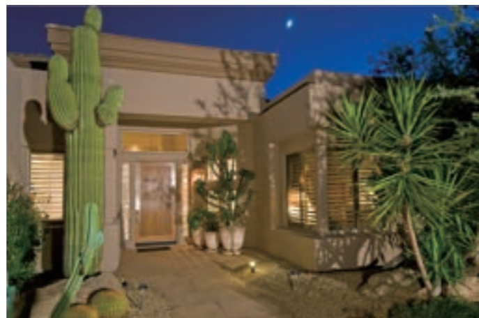
クラック補修後、リニューで仕上げ塗装 (アリゾナ州)
