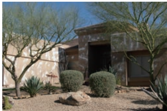
他社スタッコの施工で発生した無数のクラック補修
